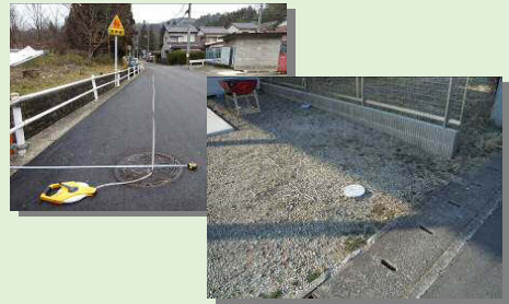
下水道施設現地調査
