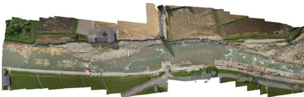
写真-5 正射投影化されたオルソ画像
