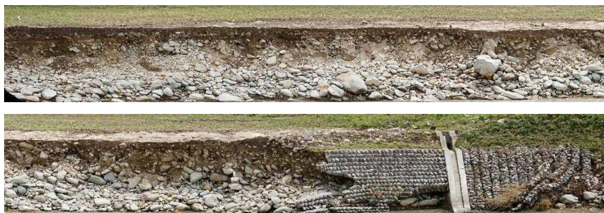
写真-6 オルソ画像による護岸被災状況
