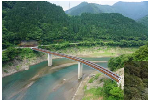
橋の工事状況
