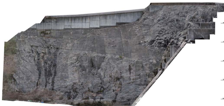
写真-10 調査対象法面のオルソ画像（高さ60m、幅100m）
